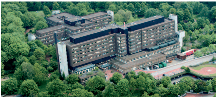
Die Mühlenkreiskliniken (NRW) wie hier das Krankenhaus Lübbecke werden mithilfe von umfangreichem Telemedizin-Einsatz neu strukturiert.
